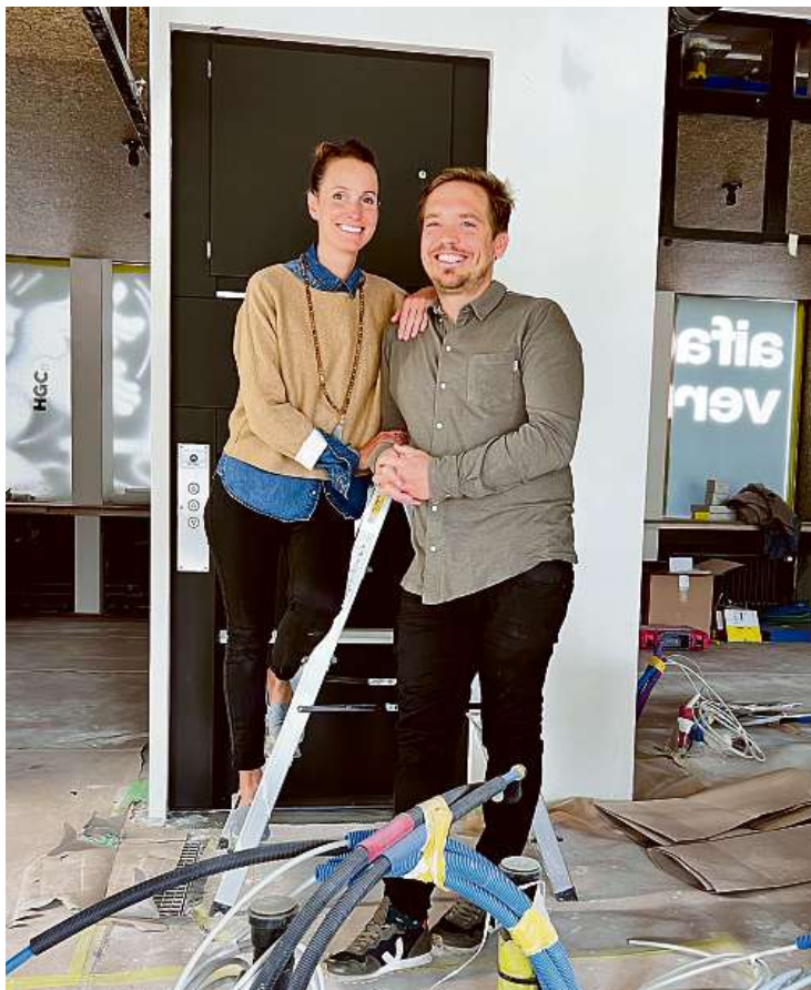
Larissa und Mark Stalder auf ihrer Baustelle.
